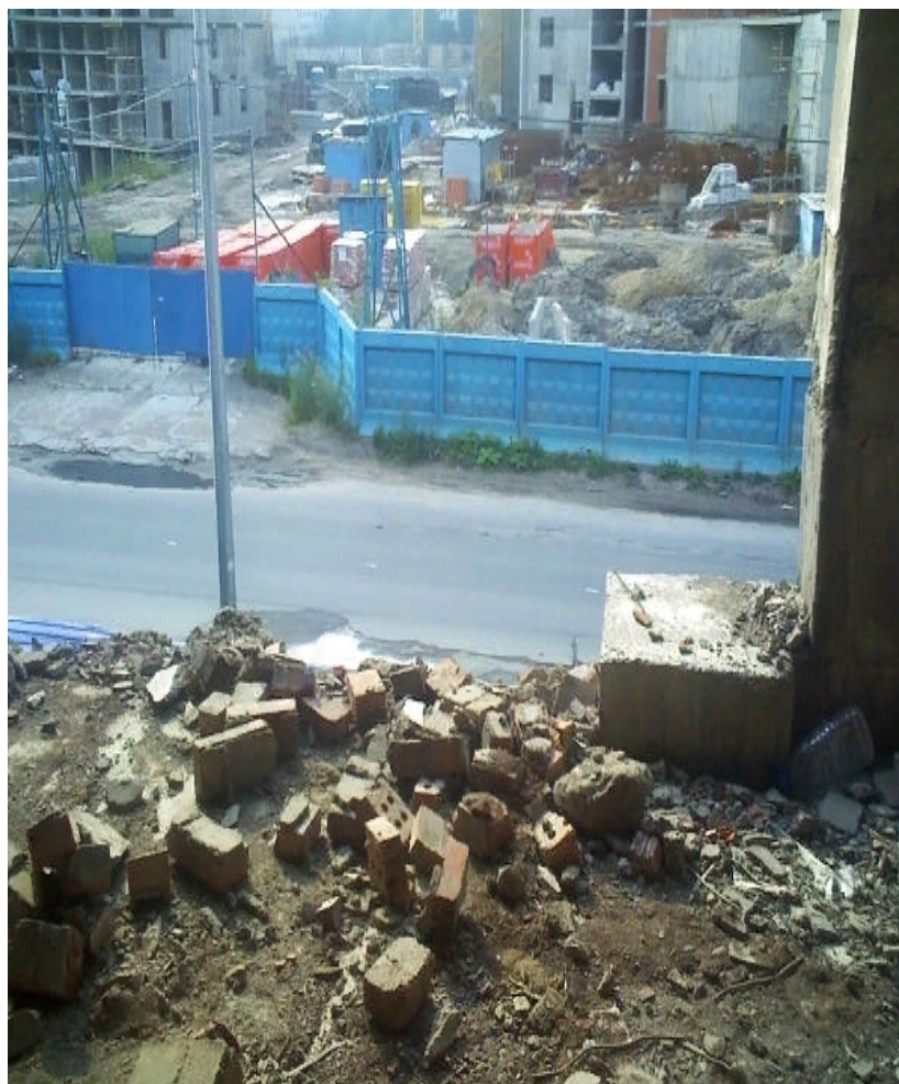
Опасные для жизни и здоровья объекты: заброшенные сооружения (7)
