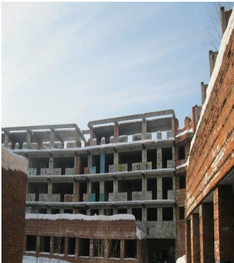
Опасные для жизни и здоровья объекты: заброшенные сооружения (2)
