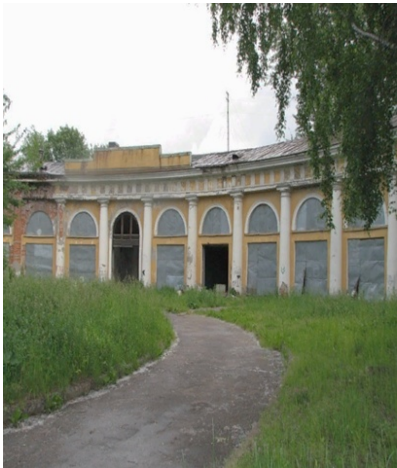
Опасные для жизни и здоровья объекты: заброшенные сооружения (8)
